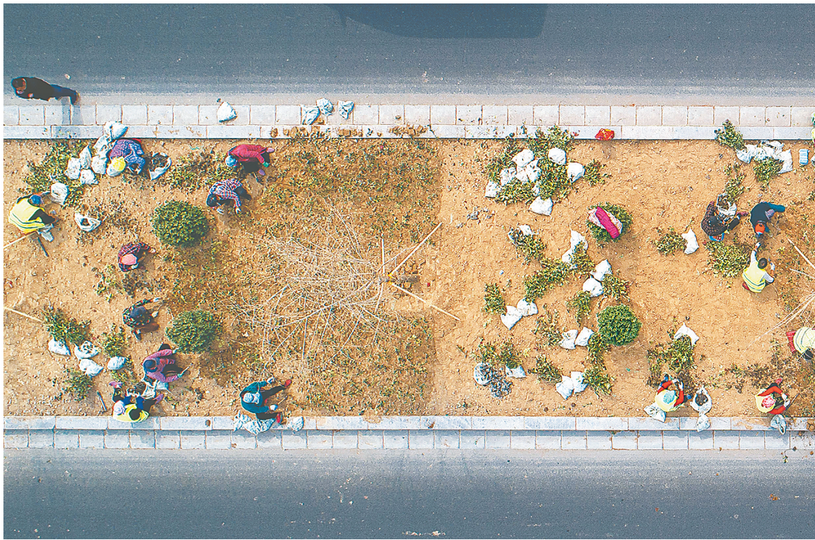
2月24日,工人在张巡西路绿化带内补栽绿植,营造良好道路景观效果。
