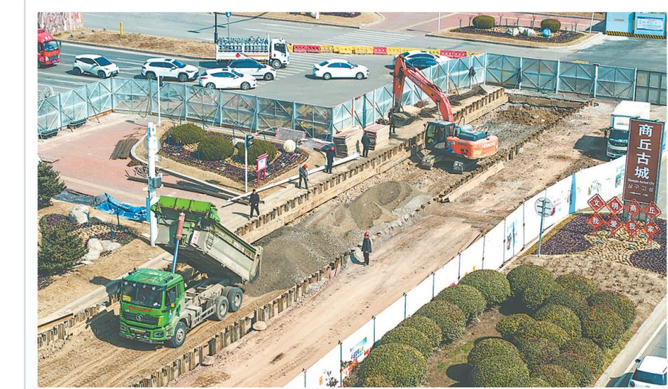
▲2月26日，施工机械在华商大道积水点改造施工现场作业。此次改造旨在解决雨季积水难题，提升居民出行舒适度与安全性，改善城市排水系统，让城市在雨天也能“畅快呼吸”。
