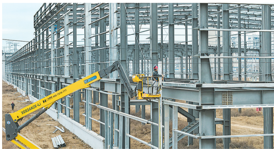
1月7日,工人在润雅科技股份有限公司7GWh钠离子电池生产制造项目施工现场作业。该项目是豫商经济技术开发区重点招商引资项目,总投资25亿元,建成投产后可实现年营业收入40亿元。 本报融媒体记者 崔坤 摄
